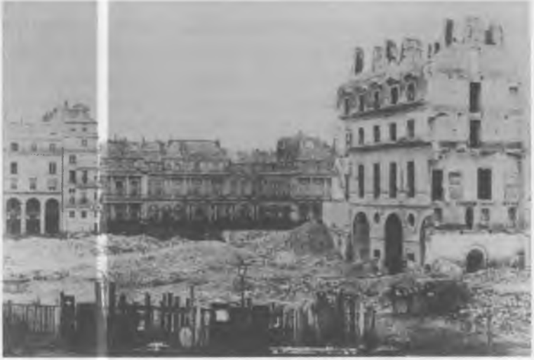
RESİM 5 1850-1851 civarında Marville tarafından çekilmiş bu fotoğraf Rue de Rivoli ve Palais çevresinde süregiden yıkımları gösterir.
