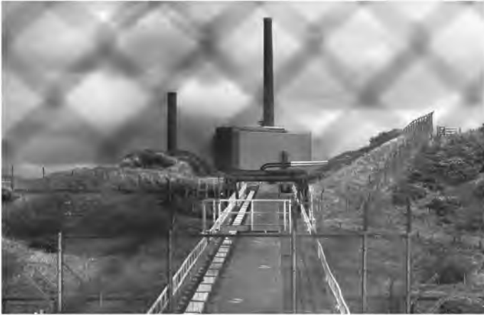
İngiltere'deki Sellafield Nükleer Enerji Santrali'nin atık bacasına bakış.
