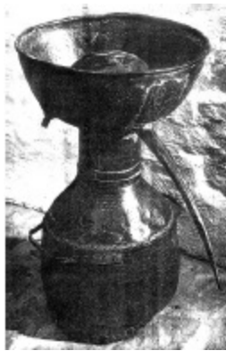
ŞEKİL 71. Bakırdan yapılmış damıtma aleti (Erken 17. yüzyıl): Burada, “Mağripli kafası” (“Mohrenkopf”) adı verilen türde bir damıtma düzeneği görülmektedir. Damıtma kabının üst kısmında soğutma başlığı (imbik) bulunmakta; bu kısma konan soğuk suyun soğutma etkisiyle, buraya ulaşan buharlar yoğunlaştırılmaktadır (Alman Eczacılık Müzesi, Heidelberg). 47
