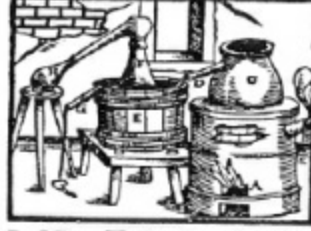
ŞEKİL 91. Conrad Gesner'den çevrilen Arzneibuch (Zürich, 1583) adlı eserin başlık sayfasında damıtma düzeneği.141
