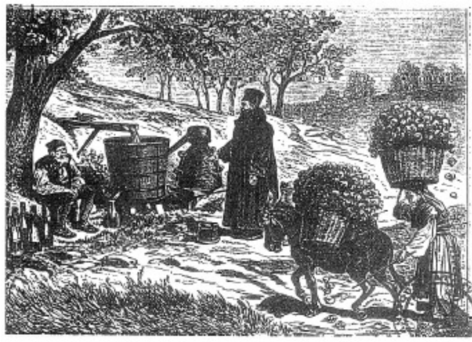
ŞEKİL 93. Bulgaristan'da gülyacı üretimi: Bu basit düzenekte, odun yakılarak ısıtılan damıtma kabından çıkan damıtma ürünleri, damıtma başlığının tepesinden çıkıp aşağıya uzanan iletim borusu ile içi soğutma suyu dolu olan bir fiçinin içinden boylu boyunca geçmekte ve ürün, aşağıdan şişelere toplanmaktadır (ahşap oyma resim, ~1880). 141
